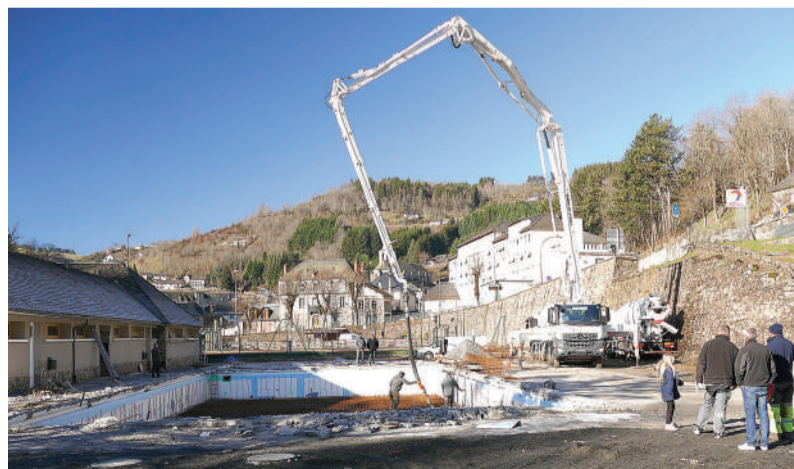
Les travaux sont en cours.
